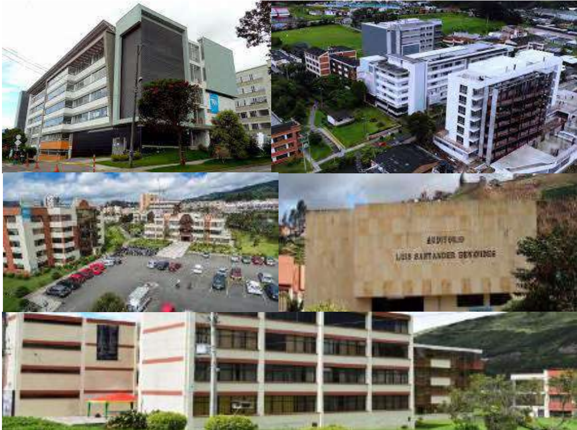
Infraestructura Universidad de Nariño sede Pasto
