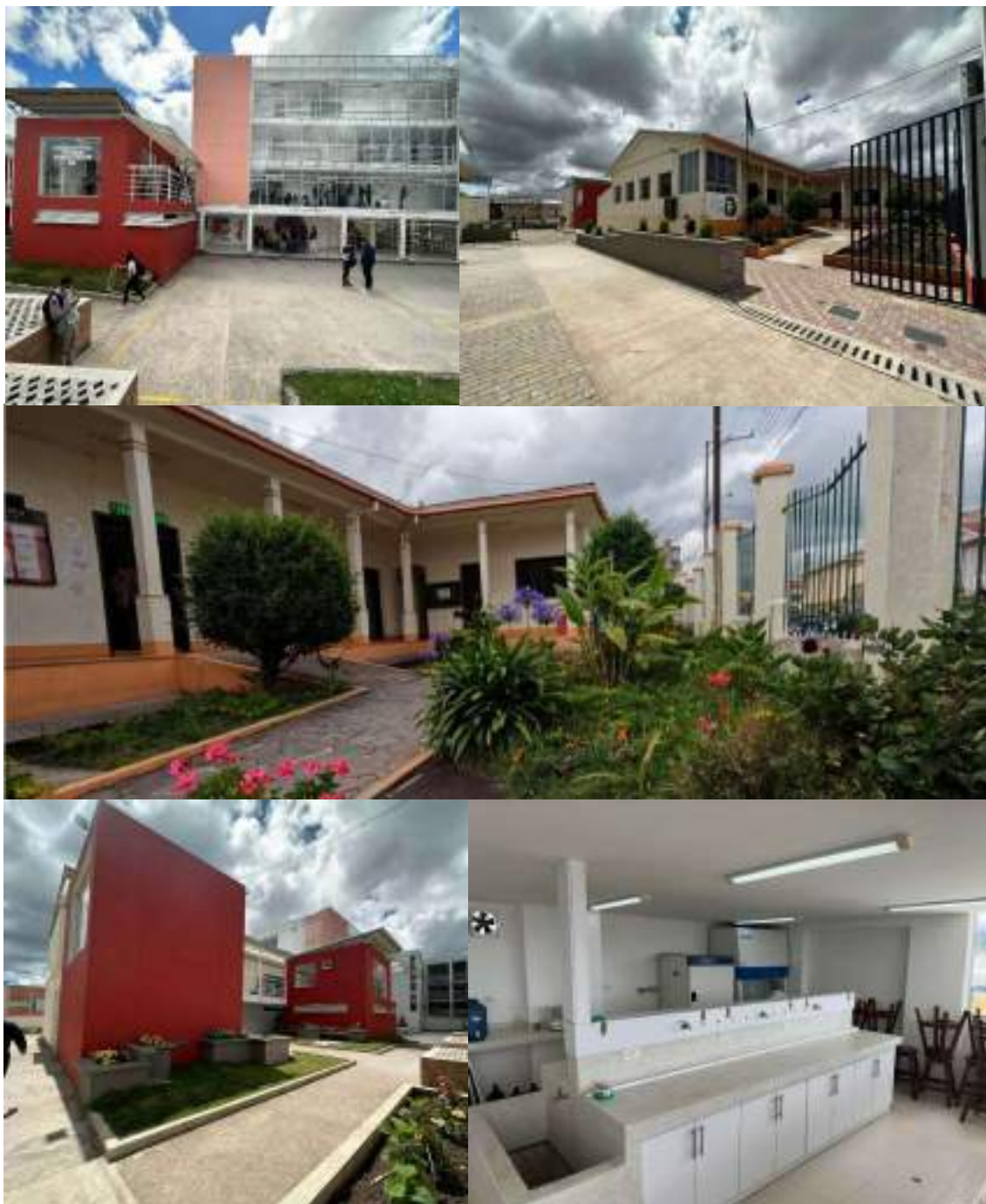
Imágenes de infraestructura sede Túquerres
