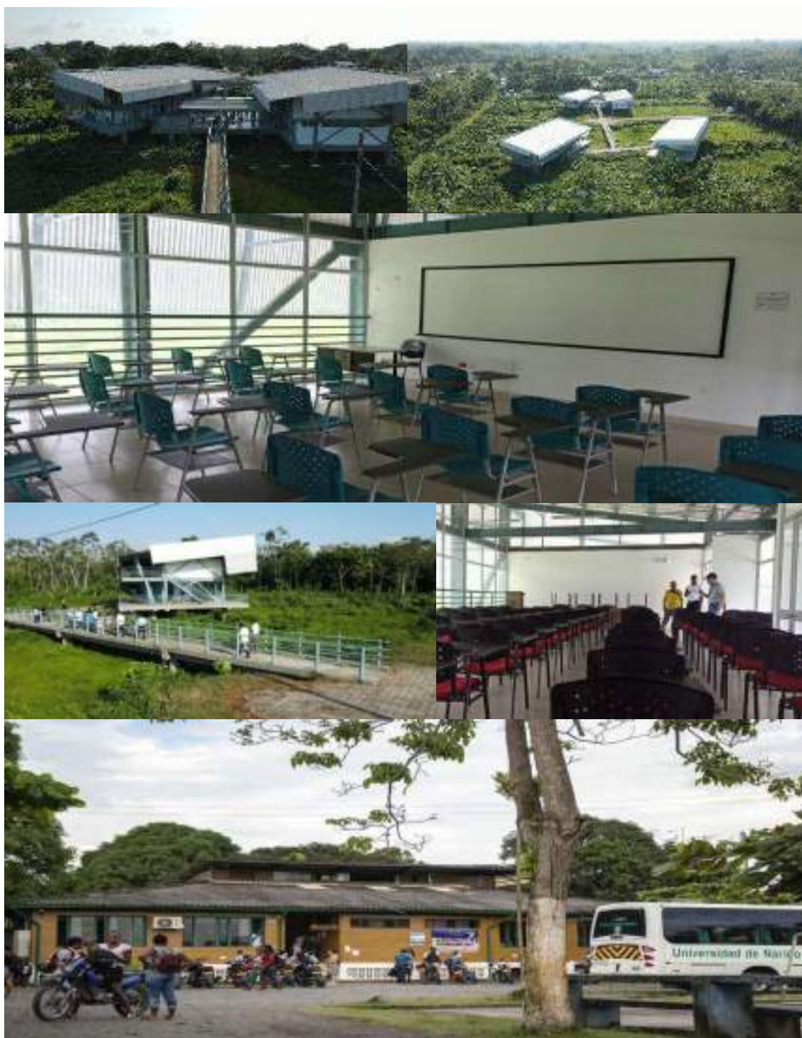
Imágenes de infraestructura física sede Tumaco
