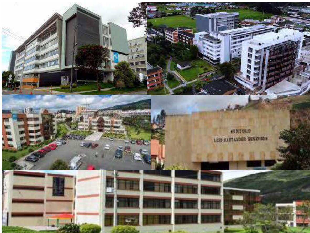
Infraestructura Universidad de Nariño sede Pasto
